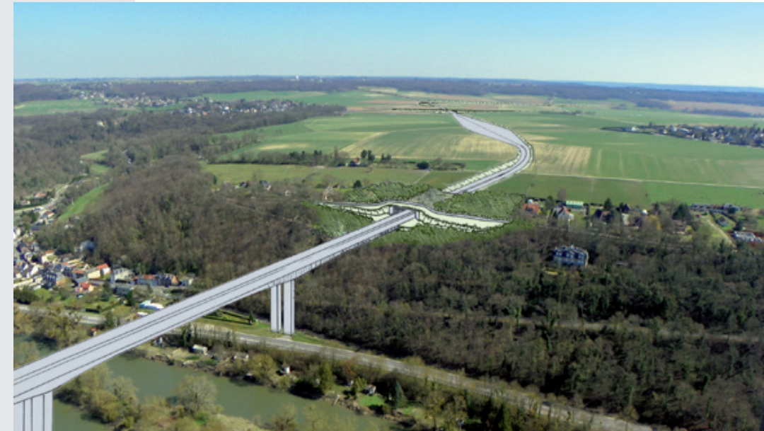
> VUE SUR LA TRANCHEE EN RIVE DROITE A HAUTEUR DE LA COMMUNE DES AUTHIEUX-SUR-LE-PORT-SAINT-OUEN [VEGETUDE, 2015]
