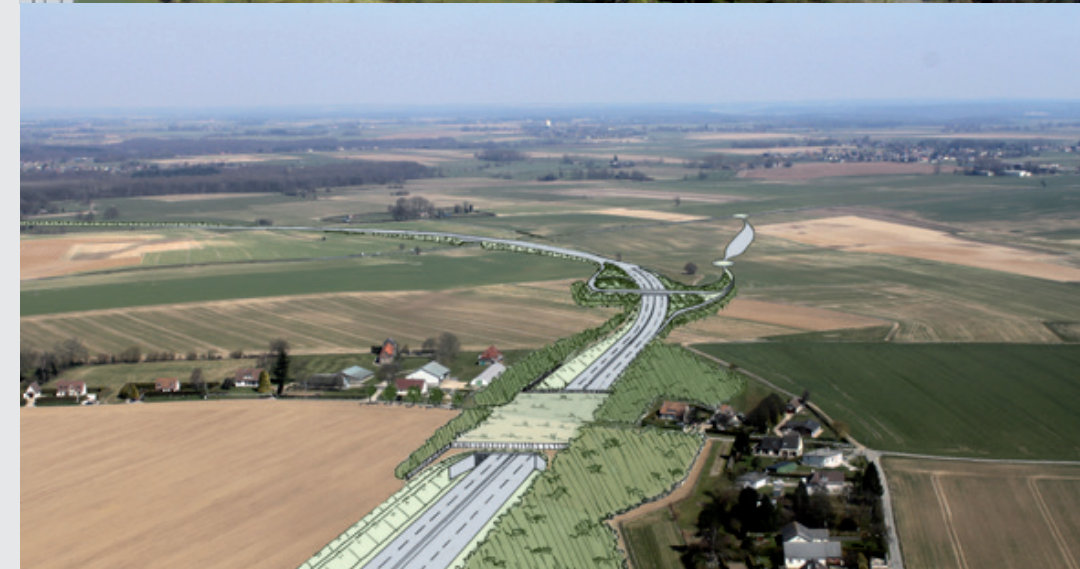
> VUE SUR LE PASSAGE EN TRANCHE COUVERTE A HAUTEUR DU HAMEAU DU BOC [VEGETUDE, 2015]
