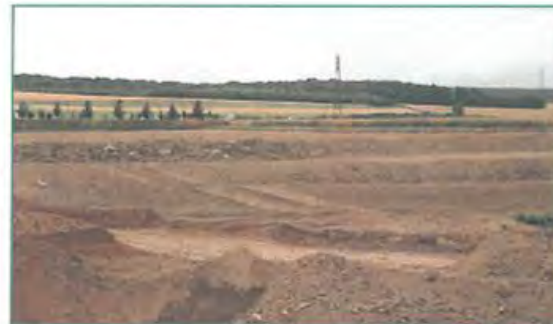
Vue sur les terrains de la carrière actuelle en cours de remblaiement, à l'Ouest du site (avec en fond la RD.321 et le Bois du Tailis).
