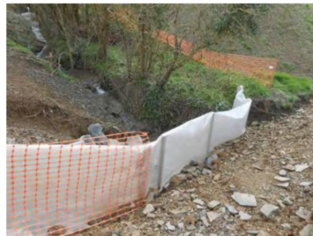
FIGURE 354 : EXEMPLE DE GEOTEXTILE EVITANT L'ÉBOULEMENT DE MATERIAUX DANS LE COURS D'EAU [ARTELIA]
