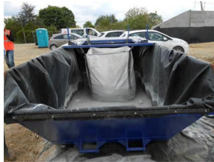
FIGURE 353 : EXEMPLE DE TRAITEMENT DES LAITANCES DE BETON [ARTELIA]
