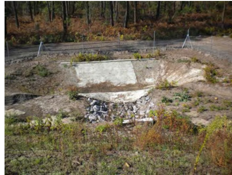
FIGURE 208 : EXEMPLE DE FOSSE DE DIFFUSION
