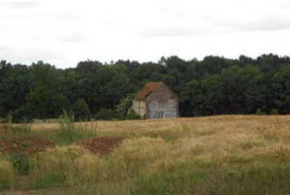
FIGURE 226 : BATIMENT EN RUINE A QUINCAMPOIX [ARTELIA®, 2013]
