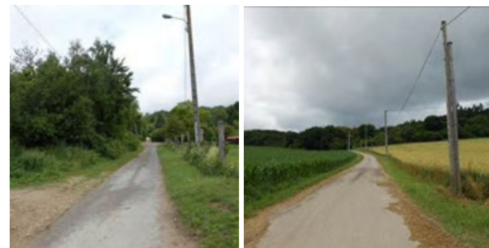
FIGURE 264 : CHEMIN DE LA VOIE BLANCHE (A GAUCHE) ET CHEMIN DES VAULOINES (A DROITE) RETABLIS PAR LE PROJET [ARTELIA©, 2013]
