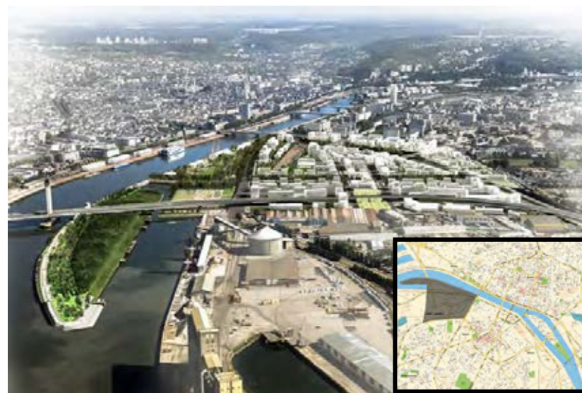
FIGURE 190: LOCALISATION ET VUE DE L'ÉCOQUARTIER FLAUBERT A ROUEN [METROPOLE ROUEN NORMANDIE]
