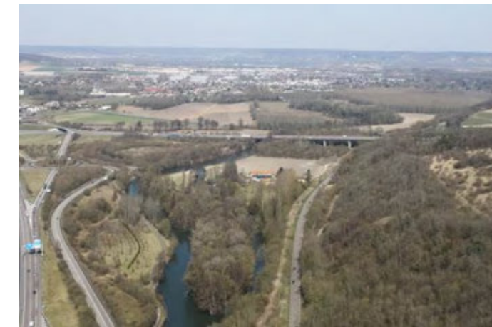
FIGURE 15 : VALLEE DE L'EURE, PRISE DE VUE AU SUD-EST DE LA BANDE D'EPDUP [ARTELIA©, 2013]
