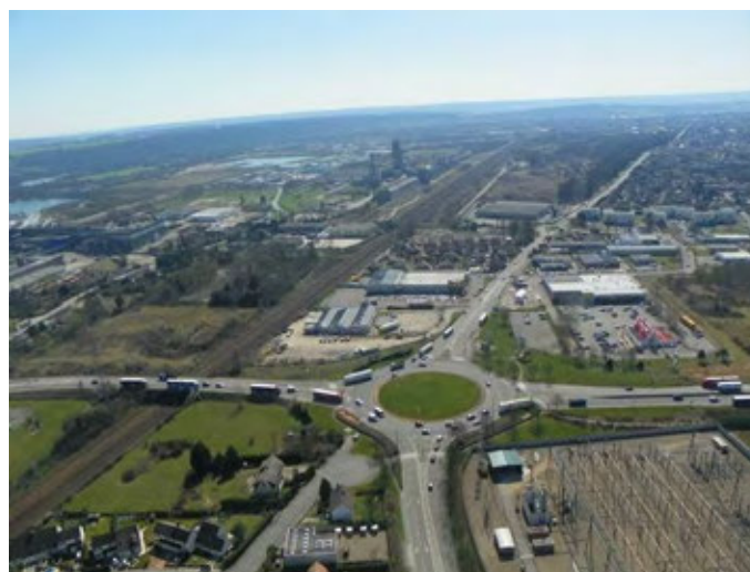
FIGURE 45 : ZONE INDUSTRIELLE D'OISSEL VUE DEPUIS LE NORD [ARTELIA©, 2013]
