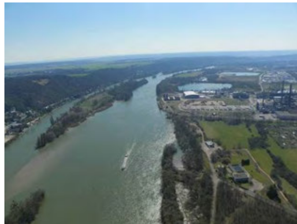
FIGURE 12 : VALLEE DE LA SEINE AU NIVEAU D'OISSEL, VUE DEPUIS LE NORD SUR LA BANDE D'EPDUP [ARTELIA©, 2013]
