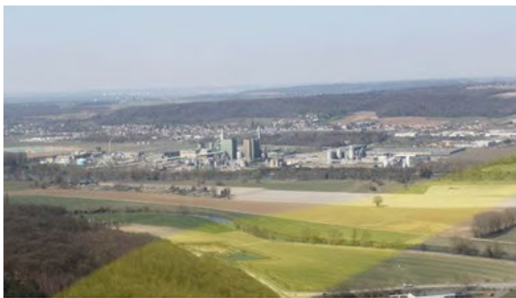
FIGURE 49 : ZONE INDUSTRIELLE DU CLOS PRE VUE DEPUIS LA FORET DE BORD [ARTELIA©, 2013]
