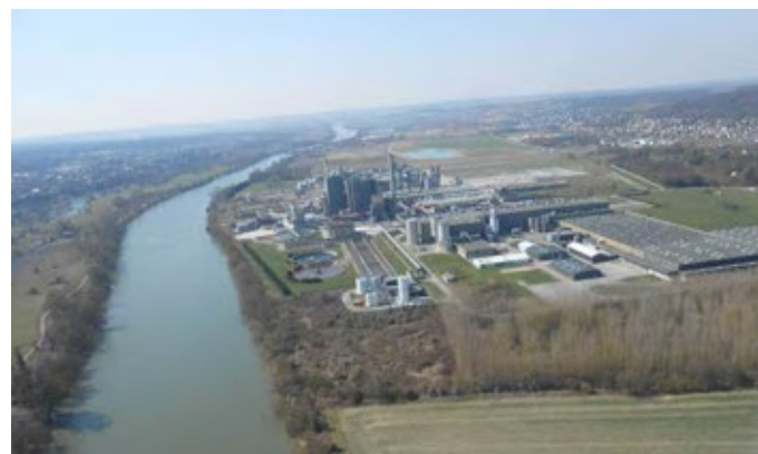
FIGURE 14 : VALLEE DE LA SEINE ET DE L'EURE, VUE SUR LA PLAINE ALLUVIALE [ARTELIA©, 2013]
