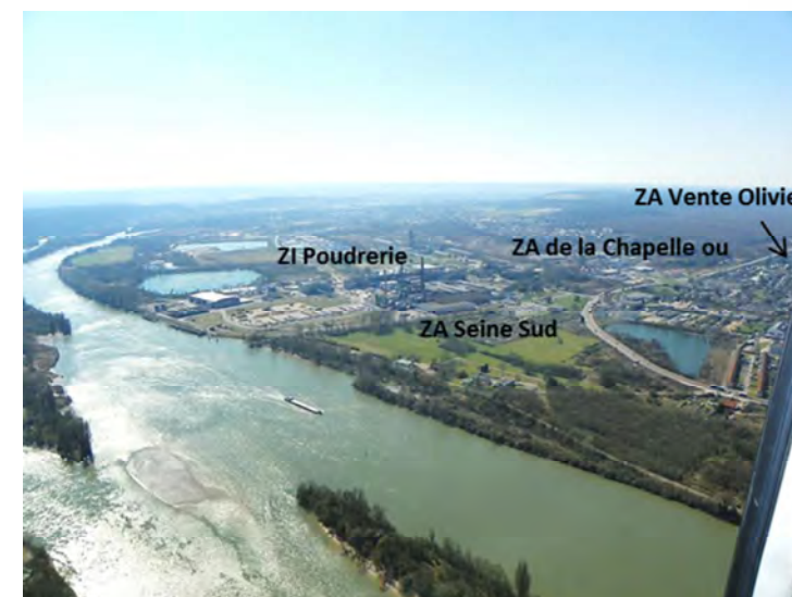
FIGURE 47 : LOCALISATION DES ZONES D'ACTIVITE AUTOUR DE LA RD18E, VUE DEPUIS LE NORD-EST [VEGETUDE ©, 2013]
