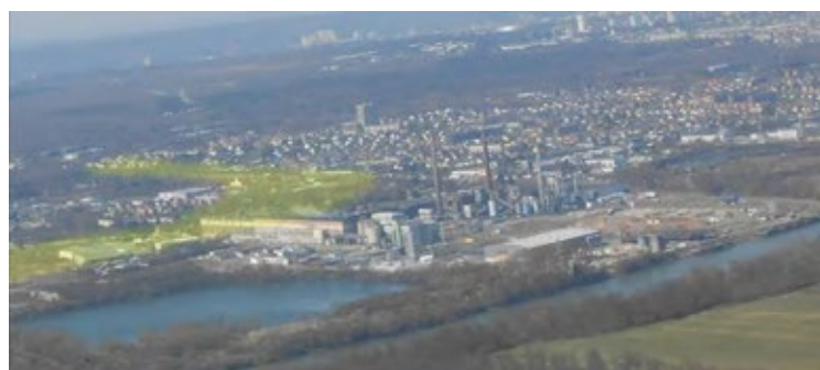
FIGURE 46 : VUE SUR LA PAPETERIE EUROPAC DE LA ZONE SEINE-SUD DEPUIS LE SUD-EST [ARTELIA©, 2013]
