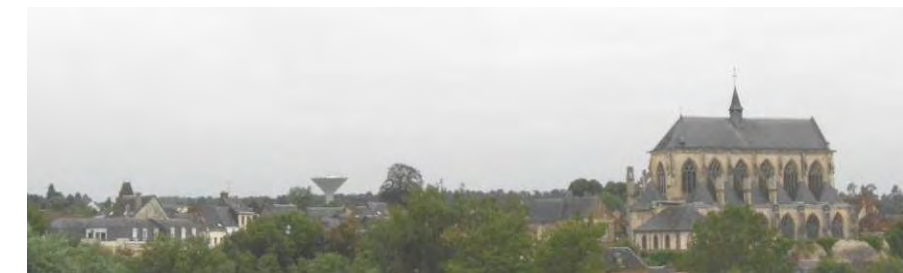
FIGURE 113 : CENTRE-VILLE DE PONT-DE-L'ARCHE [ARTELIA©, 2013]
