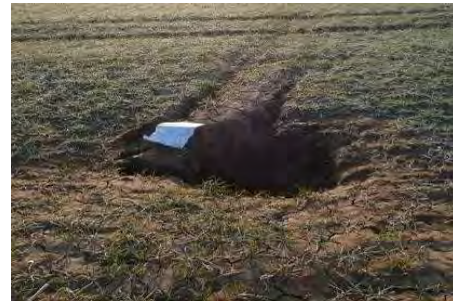
FIGURE 125 : EXEMPLE DE BÉTOIRE ACTIVE
