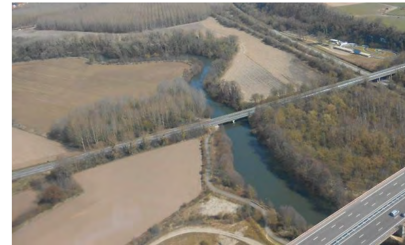
FIGURE 45 : L'EURE AU NIVEAU DE LA TRAVERSEE DE L'A13 [ARTELIA]
