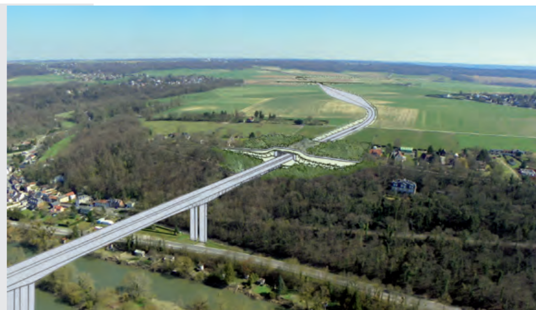
FIGURE 8 : VUE SUR LA TRANCHEE EN RIVE DROITE A HAUTEUR DE LA COMMUNE DES AUTHIEUX-SUR-LE-PORT-SAINT-OUEN [VEGETUDE, 2015]
